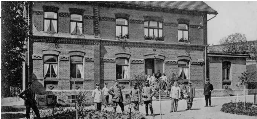
Am Bezirkskrankenhaus Ochsenhausen und im benachbarten evangelischen Schulhaus wurde ein Lazarett eingerichtet.
