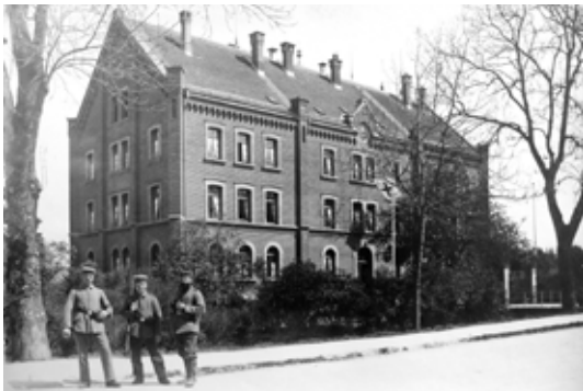
Lazarett-Außenstelle Städtisches Spital (Roter Bau) Biberach.
