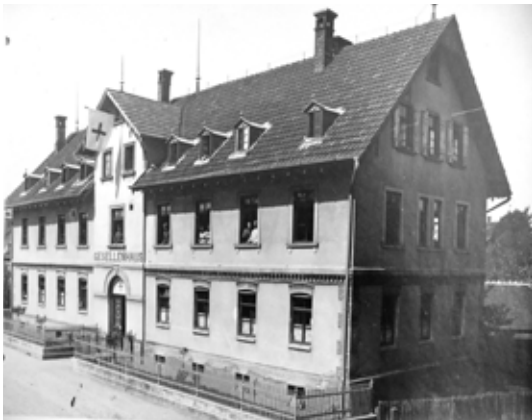
Lazarett-Außenstelle Kath. Gesellenhaus Biberach. In der heutigen Kolpingstraße, wo jetzt das 2006 errichtete Alfons-Auer-Haus steht.
