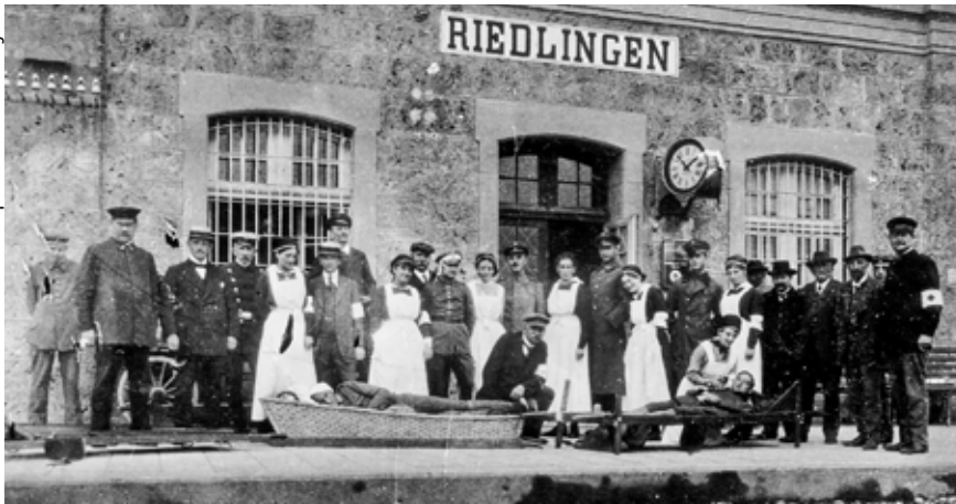
Am Bahnhof Riedlingen eingetroffene Verwundete werden abgeholt, um in ein Lazarett gebracht zu werden.
