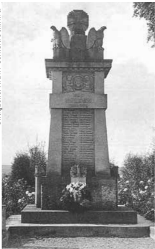
Das ehemalige monumentale Kriegerdenkmal in Ertingen um 1930.
